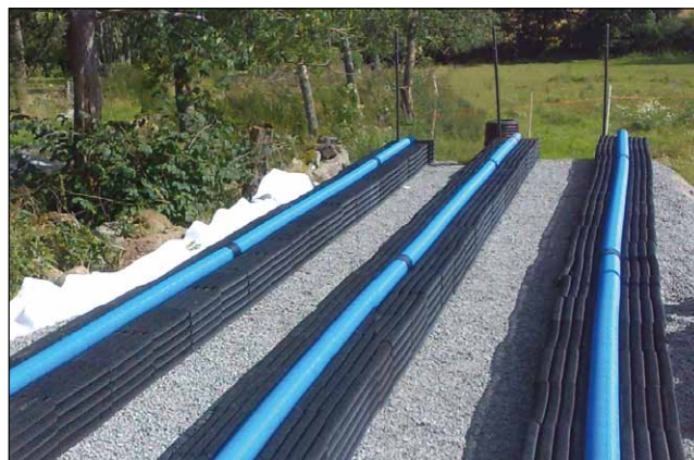
Bädd för tre hushåll, under installation.
